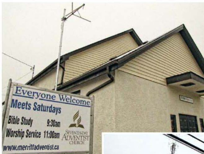
VOAR tower in Merritt, B.C.
